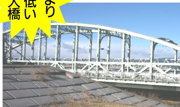
弥富市内の木曽川堤防と尾張大橋。堤防高より尾張大橋の橋けたが低く、災害対策のネックになっている
